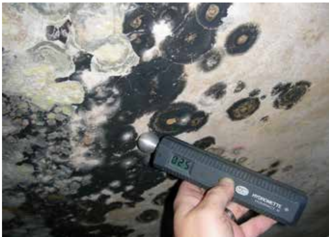
Bild 1–2: Typische Schimmelschäden
