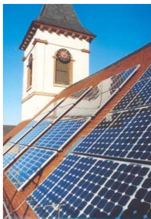
Bild 12: Solargenerator der Anlage in Billigheim
