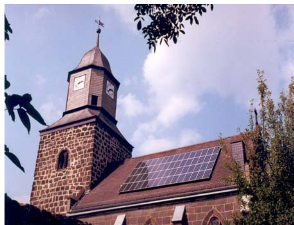
Bild 13: Solargenerator auf dem Kirchendach in Elgershausen
